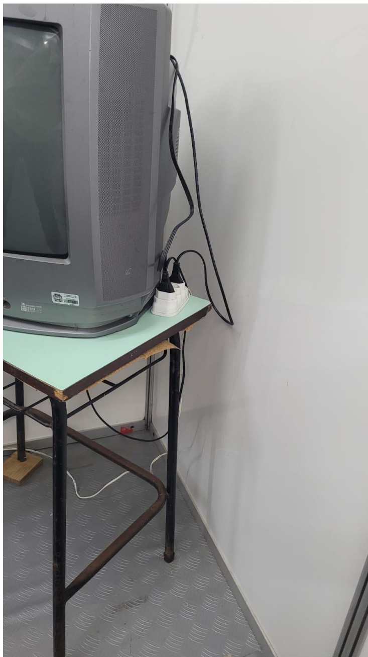
Fig. 07 - Em algumas salas, verificou-se a instalação de TV de tubo de 20 polegadas, em cima de uma classe comum, em uma altura ao alcance das crianças. A tv está ligada através de outras extensões derivadas da extensão principal, tudo ao alcance das crianças.
